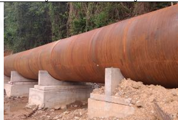
Figura 4 – Conduto em trecho exposto
