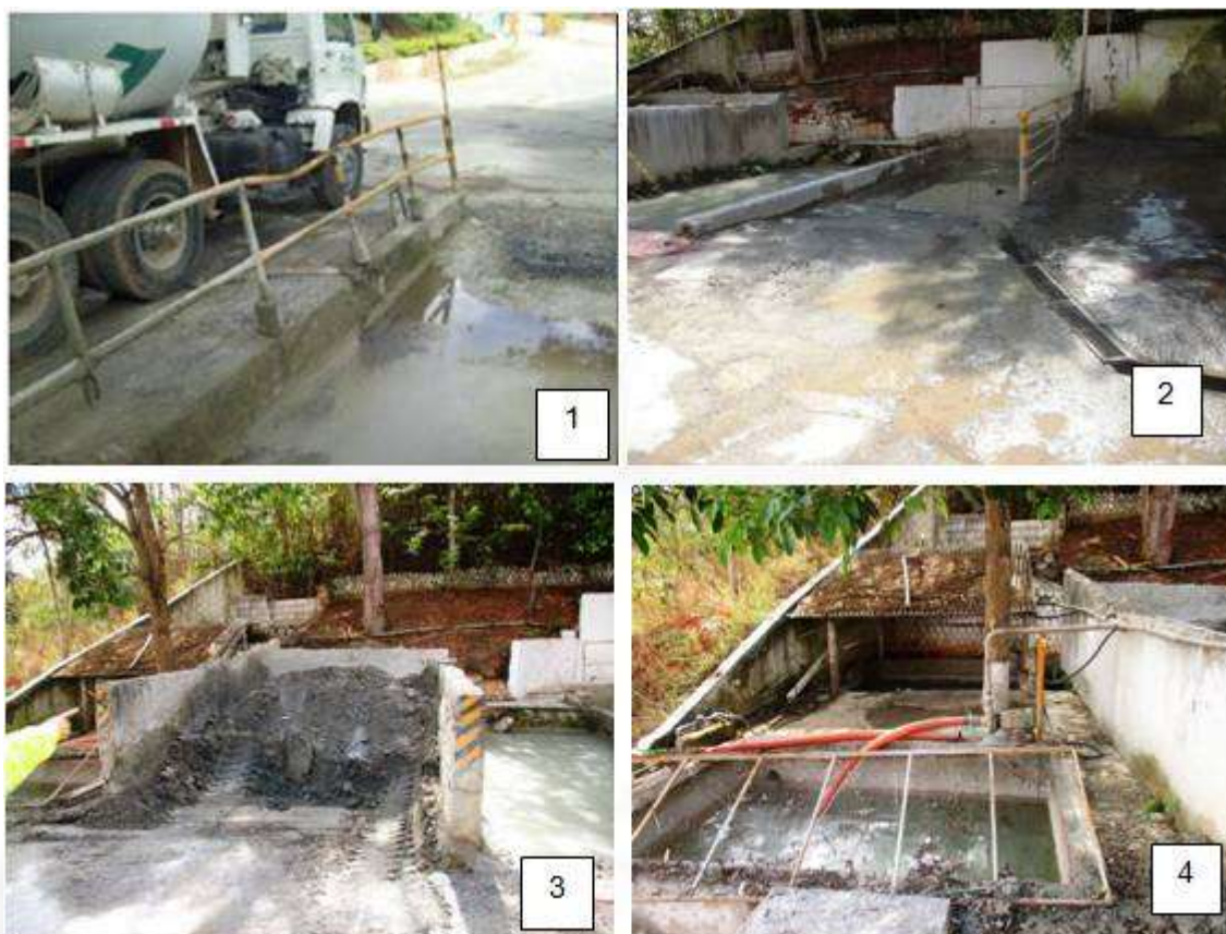
Figura 5 - Sistema de bate lastro: (1) primeira bacia de decantação à direita e lavagem dos caminhões à esquerda; (2) fotografia frontal das estruturas e sistema de drenagem de água pluvial e de lavagem de veículos; (3) depósito de rejeitos sólidos do sistema de decantação; e (4) caixa de sedimentação
