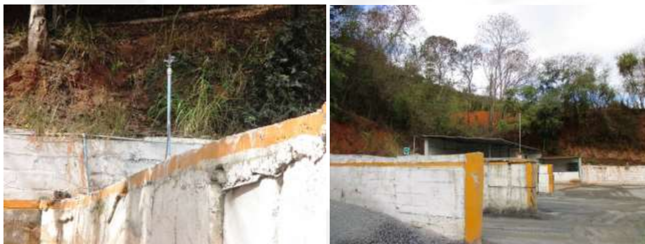
Figura 6 - Em detalhe os aspersores de água utilizados no controle de geração de efluentes atmosféricos, instalados sobre as divisas das baias de agregados
