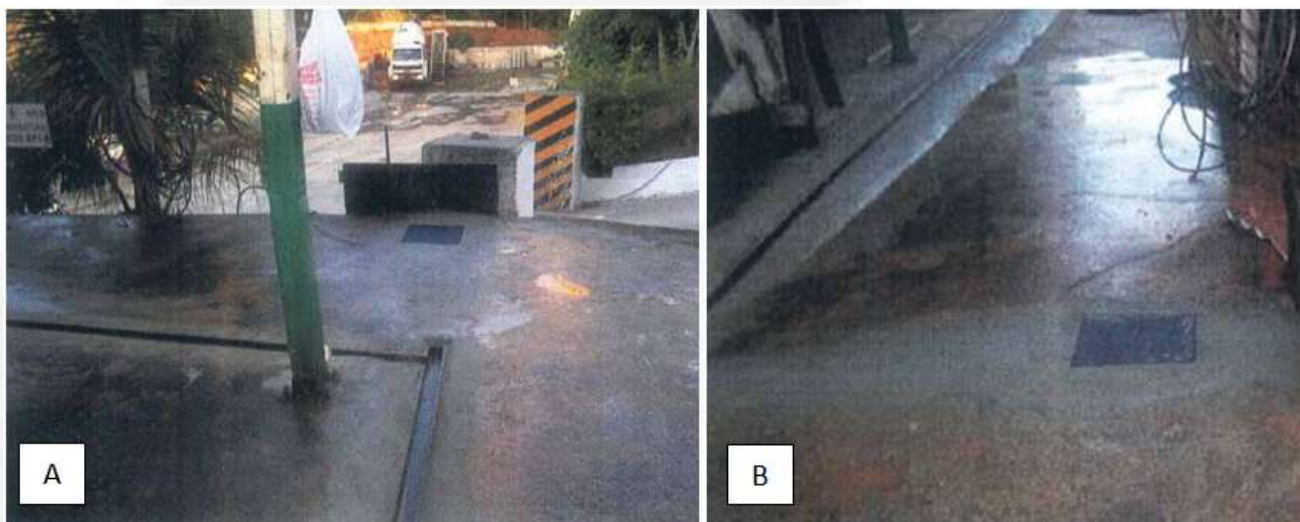
Figura 7 – Canaletas de contenção (A) e caixa SAO (B), instaladas em 2010 na oficina mecânica do empreendimento.
