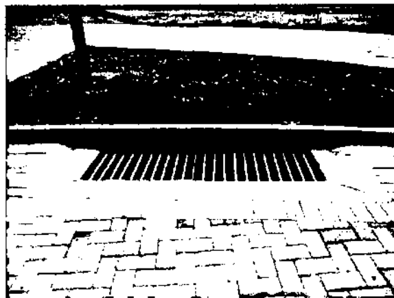
Foto 02. Drenagem pluvial existente.
