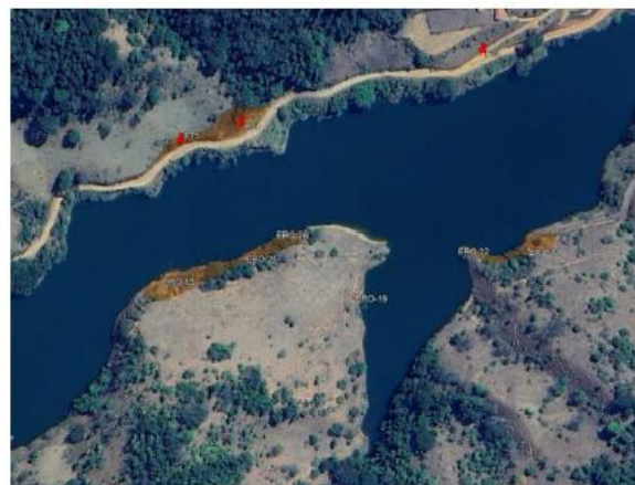
Visão das feições agrupadas próximas ao barramento, ambas as margens
