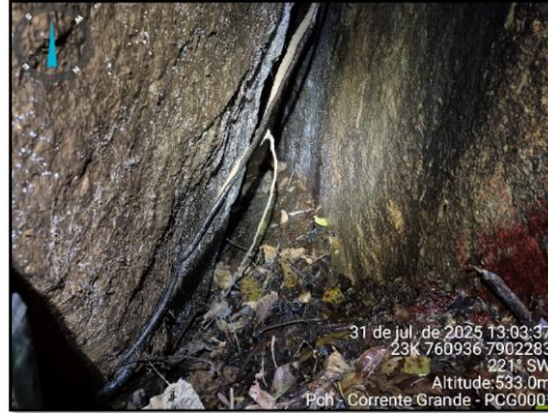
Figura 16 - Seção do conduto principal em forma de fenda, porção interna de PCG-0001
