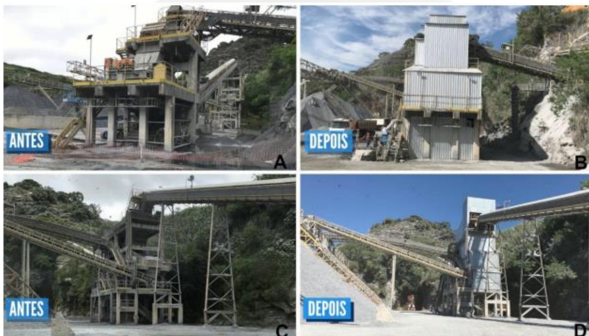
Figura 8 - Enclausuramento da unidade de britagem secundária (A e B) e do prédio de peneiramento (C e D).
