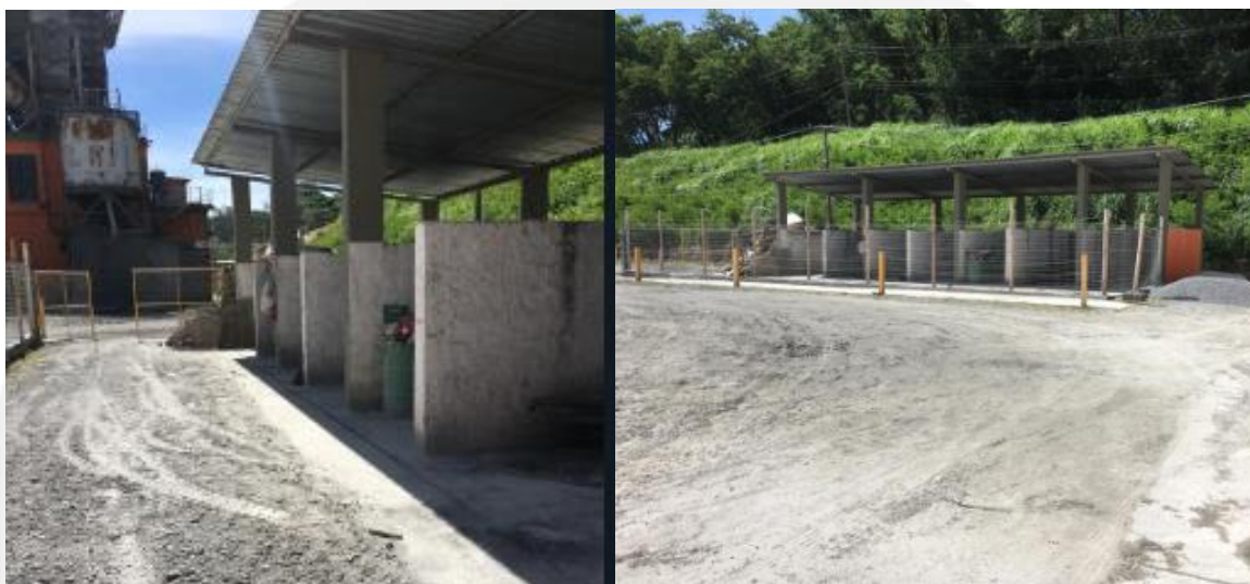
Figura 5.1.1. Baias de armazenamento de resíduos sólidos
