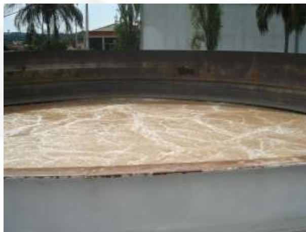
FOTO 04. Tanque de Aeração da ETE
