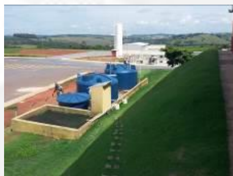
Foto 04. ETE para tratamento dos efluentes gerados no empreendimento.
