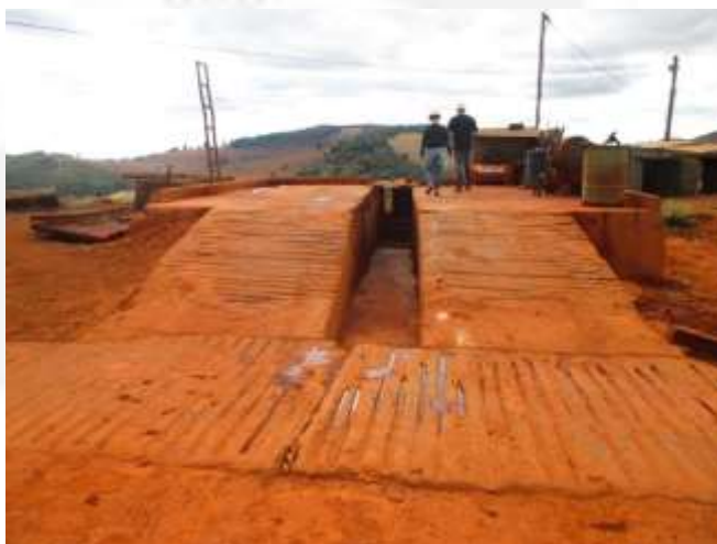
Figura 10: Lavador de veículos/maquinário
