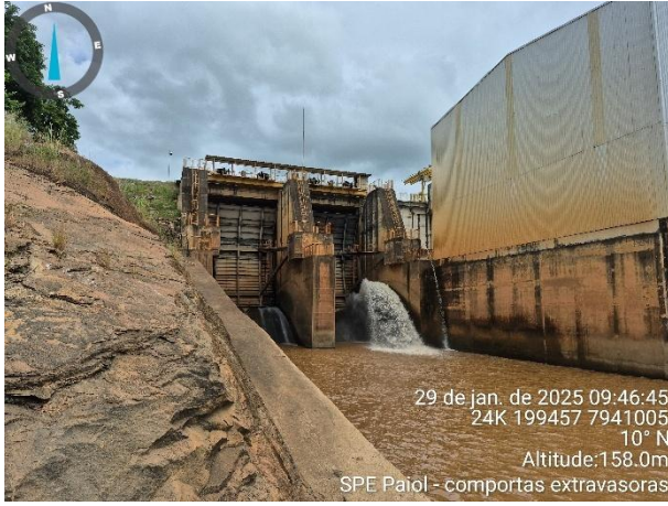
Foto 07: Vertedouro – Comportas extravasoras.
