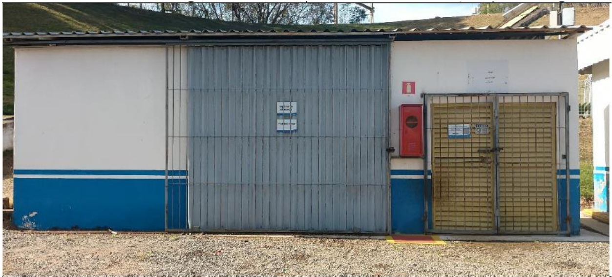
Figura 26 - Local de armazenamento temporário de resíduos não perigosos da PCH Paiol.
