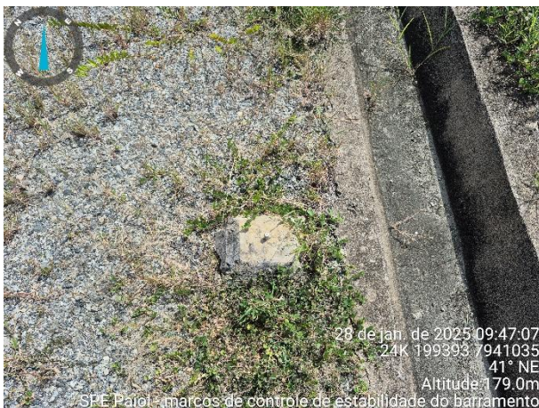
Foto 05: Marcos topográficos de controle de estabilidade do barramento.
