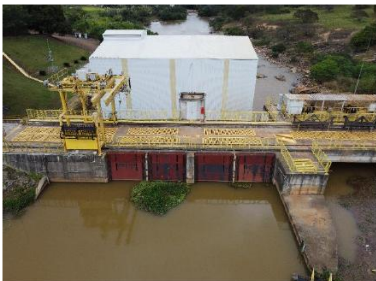
Figura 7 - Vista aérea de montante da Tomada de Água.
