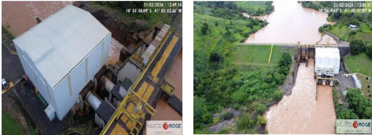
Figura 8 – Vista da Casa de Força acoplada à barragem da PCH Paiol.
