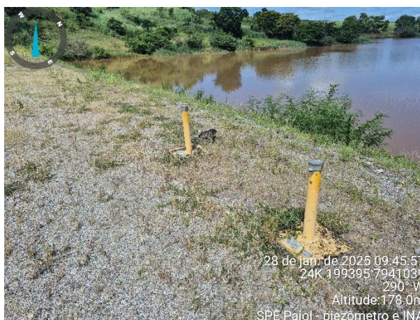
Foto 04: Piezômetros e INA existentes na crista do barramento.
