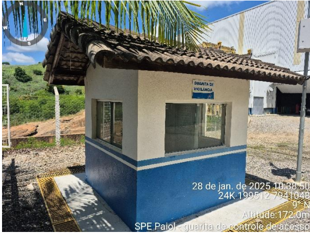
Foto 25: Guarita de controle de acessos.
