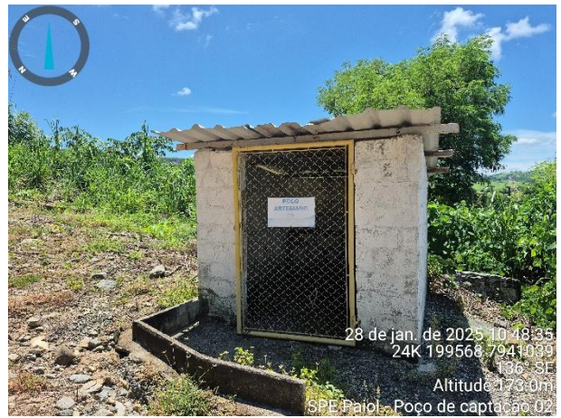
Foto 34: Local de instalação do poço 02.
