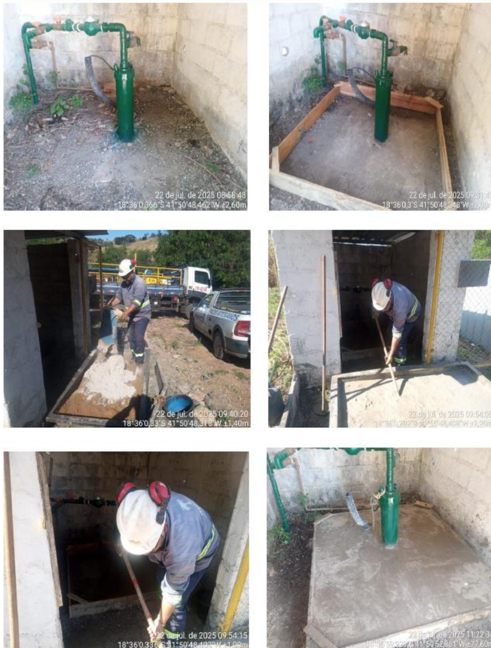
Figura 14 – Registros da instalação de laje sanitária no Poço Tubular 2.
