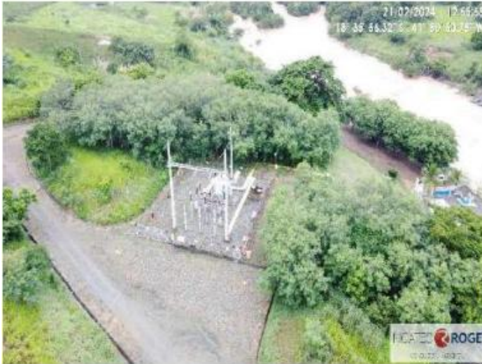
Figura 9 – Vista do entorno da subestação da PCH Paiol.
