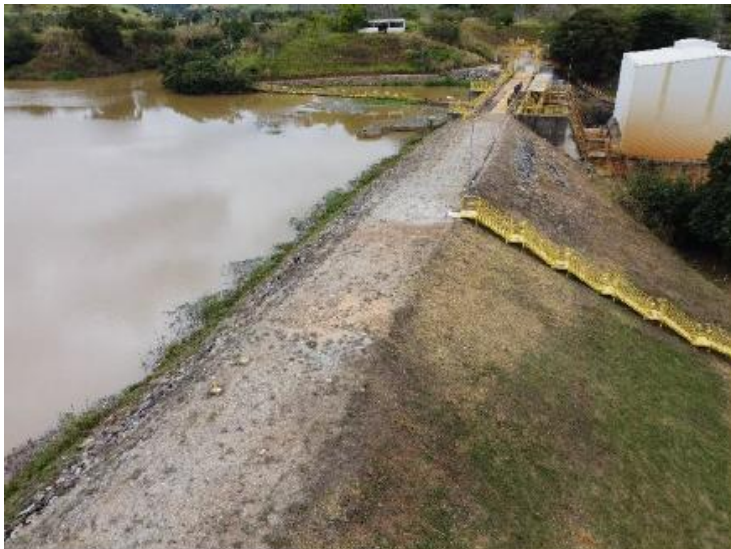
Figura 4 - Vista da crista da barragem e talude de jusante.
