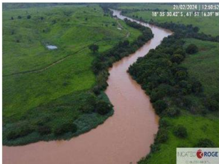
Figura 6 - Vista de trecho do reservatório da PCH Paiol.
