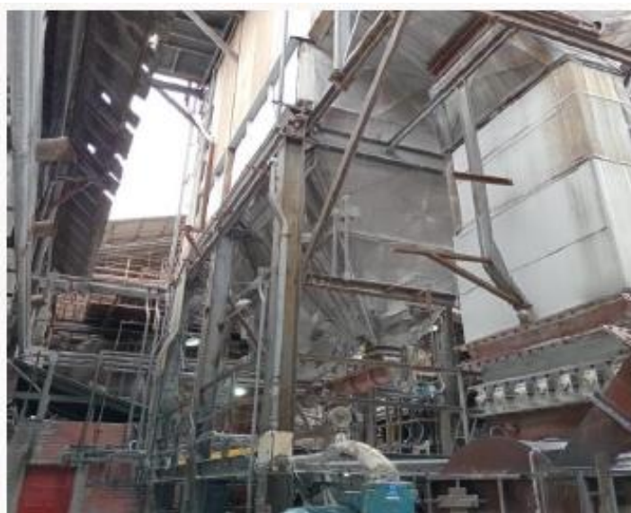
Figura 44 – Filtros eletrostáticos dos fornos calcinadores. Fonte: ACTECH.
