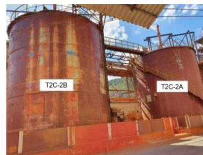
C- Tanques de pré-dessilicação
