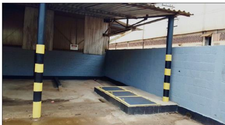
Figura 50 - Caixa Separadora de Água e Óleo instalada no galpão de resíduos oleosos do empreendimento. Fonte: ACTECH, PCA 2023.
