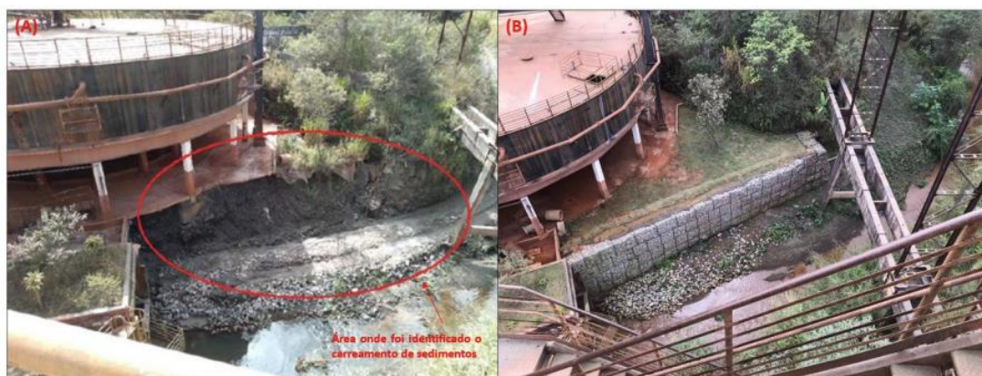
Figura 38 - (A) Área da APP em que foi identificado o carreamento de sedimentos e (B) área da APP após a instalação do muro de contenção. Fonte: ACTECH, RCA 2023.
