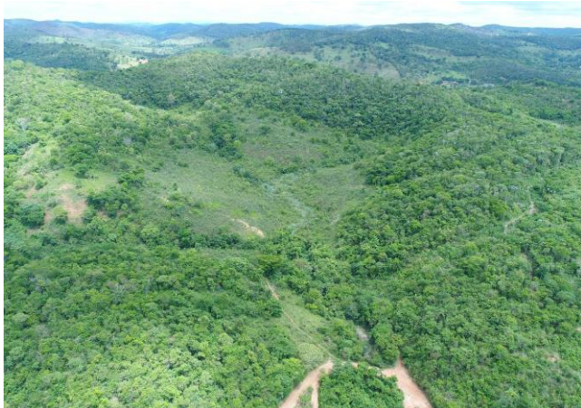
Foto 01. Vista geral Lavra Oeste.
