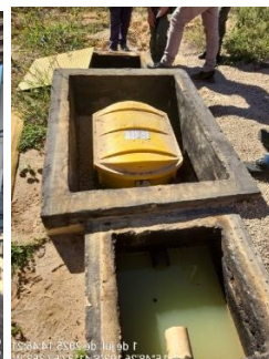
Fotos 4, 5 e 6 – Tanque de armazenamento de Diesel, pátio de manutenções mecânicas e sistema separador de água e óleo.
