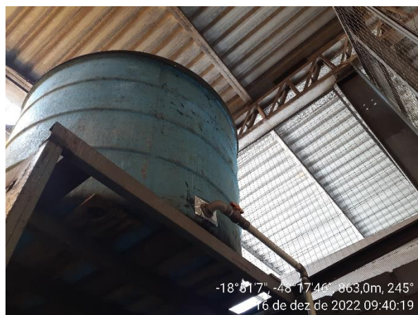
Foto 04. Caixa armazenadora de águas pluviais
