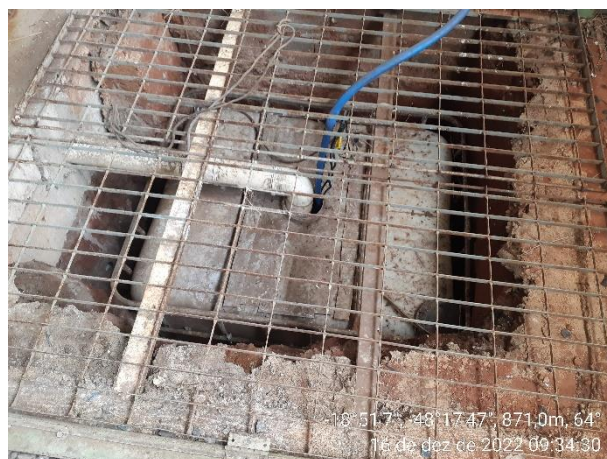
Foto 02. Caixa recebedora de efluentes
