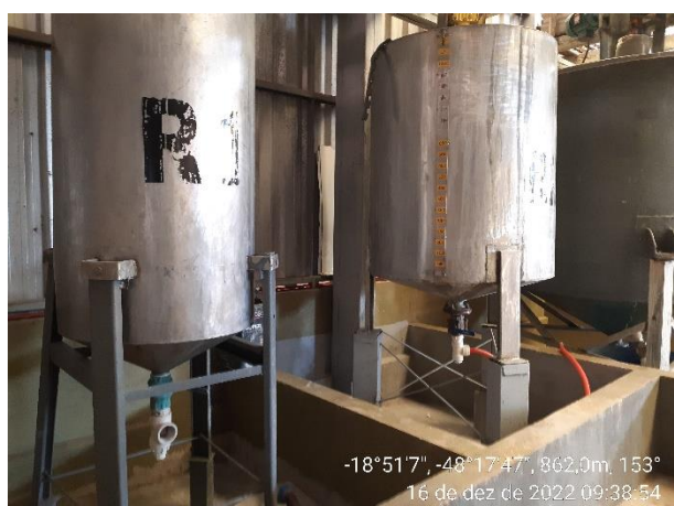
Foto 09. Tanques reatores dentro de bacias de contenção - setor agro
