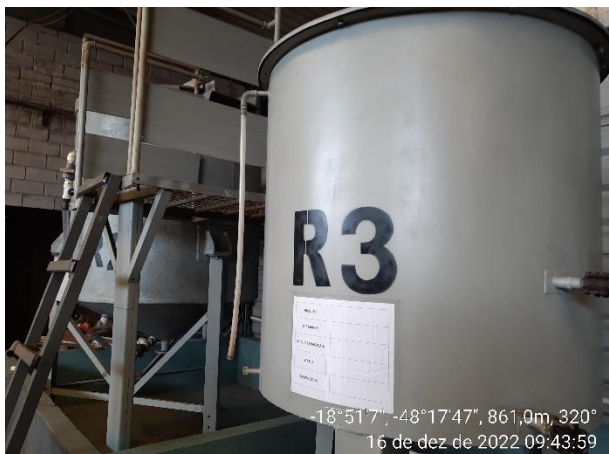
Foto 11. Tanques reatores dentro de bacias de contenção - setor saneantes
