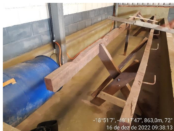
Foto 08. Bacia de contenção e suporte para recebimento de tanques - setor agro
