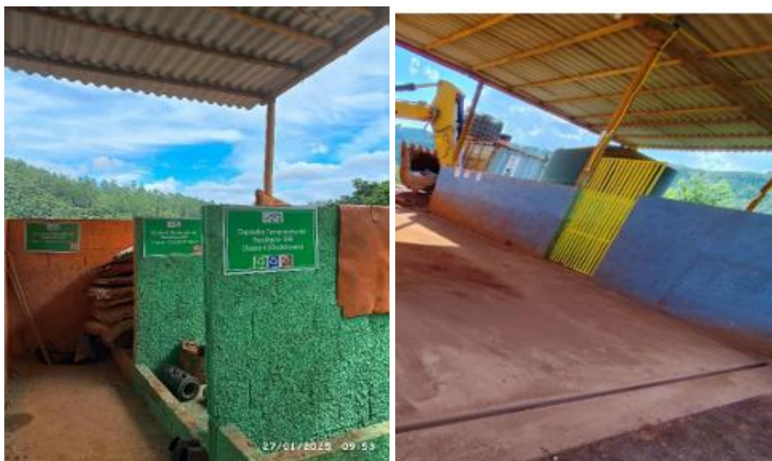
FIGURA 5: Imagens do Depósito Temporário de Resíduos (DTR), à esquerda, indicando portão de restrição de acesso (Fonte: informações complementares, Id SLA 392728)
