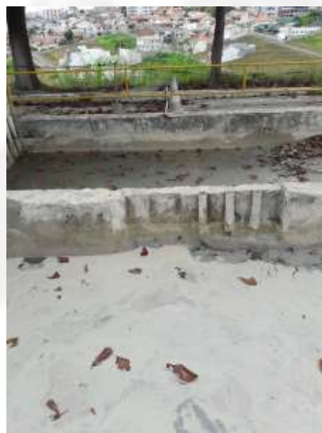
Foto 04. Tanques de decantação/sedimentação.
