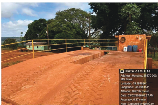
Foto 01. Vista – Lavador de veículos
