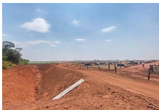
Foto 02. Lagoa de estabilização em construção
