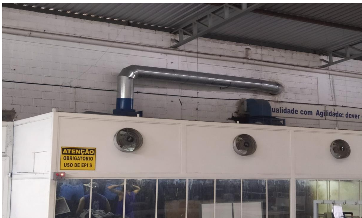
Figura 7 - Visão da cabine de jateamento de Permanganato de Potássio, com detalhe do ducto de exaustão.
