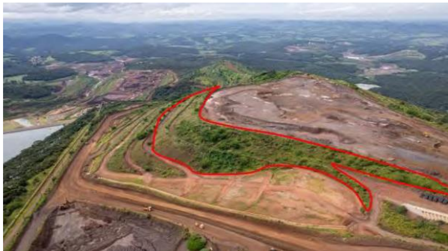
Figura 23 - Talude leste da PDE Menezes III onde ocorreu o crescimento de indivíduos arbóreos sobre o rejeito depositado na pilha. Fonte: PIA adequação da drenagem DTR-05 e Anexo e Remoção de Rejeitos na Pilha de Depósito de Estéril (PDE Menezes III). Vale, 2024.
