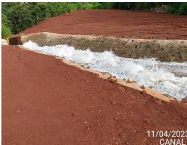
Figura 6 - Canal Leste recuperado com estrutura provisória. Fonte: Pia dos Projetos implantados em caráter emergencial, Vale, 2024.
