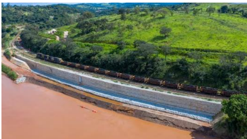
Figura 17 - Estabilização do talude da Ferrovia MRS. Fonte: PCIA Projetos Diversos, Vale 2024.
