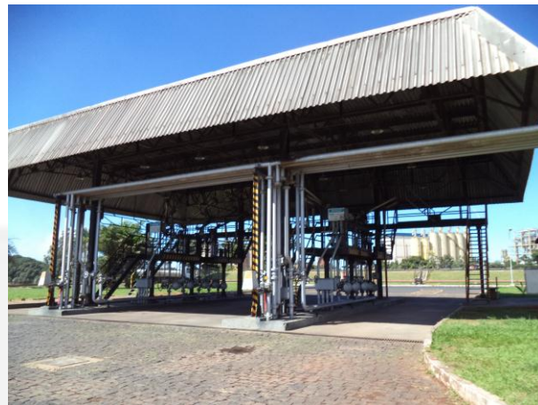
Foto 06. Ilha de carregamento
