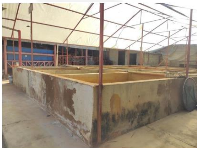
Figura 03: Leitos de secagem do lodo gerado na ETE Industrial.
