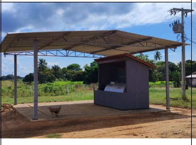
Foto 04: Área de abastecimento com cobertura e sistema de drenagem do efluente oleoso.
