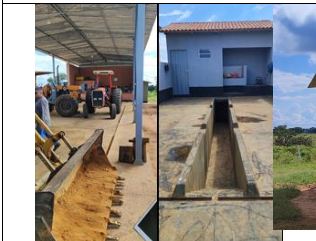
Foto 03: Galpão de máquinas e lavador de veículos com sistemas de drenagem do efluente oleoso.
