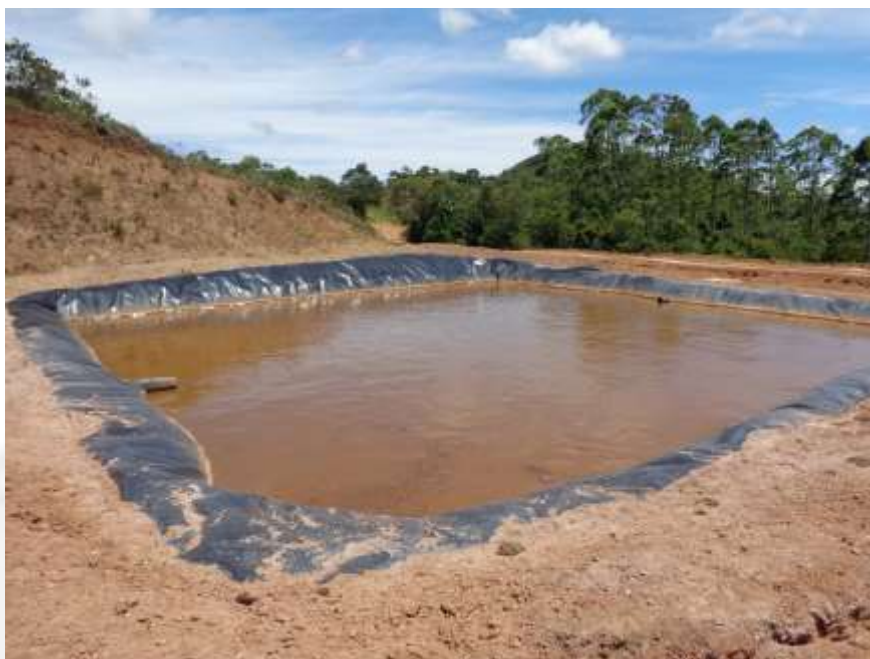
Figura 2 – Lagoa anaeróbia
