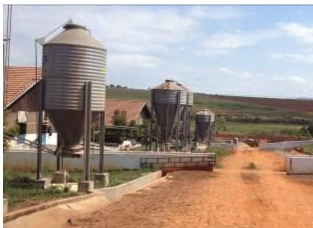
FOTO 2: Vista parcial dos Galpões da UPL com canaletas para condução da água pluvial.
