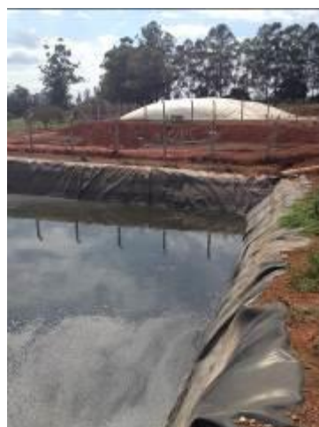
FOTO 10: Lagoa secundária e Biodigestores no fundo.
