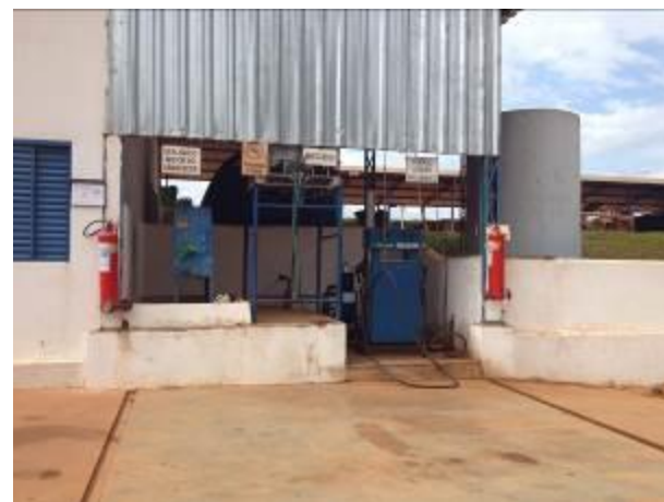
FOTO 4: Ponto de abastecimento: área cercada com canaleta refere-se à área de abastecimento, no fundo e do lado direito da imagem - parte alta - tanques de combustível dentro de bacia de contenção.
