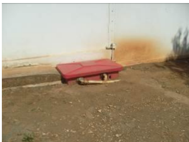
FOTO 8: Caixa Separadora de Água e Óleo – SÃO.
