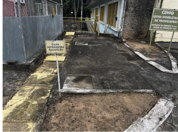
Figura 51 - Caixa SAO para atendimento à Subestação.
