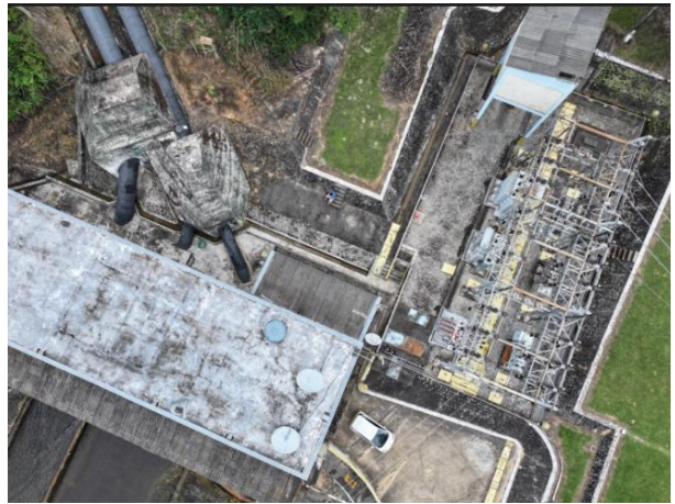
Figura 14 - Vista superior da estrutura da Casa de Força.
