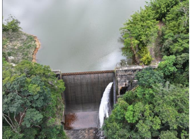
Figura 4 - Vista da barragem e vertedouro, à jusante.
