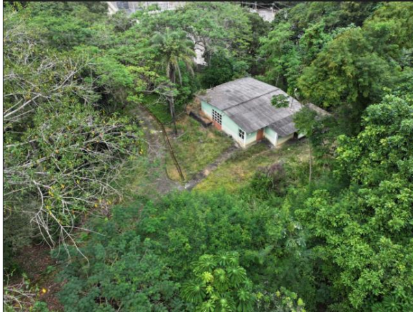
Figura 20 - Edificação na Vila.
