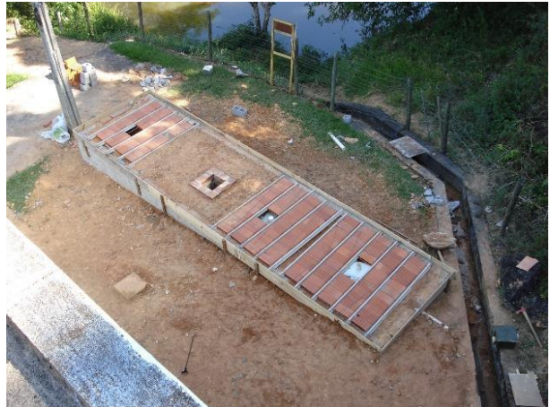
Figura 54 - Construção fossa séptica.
