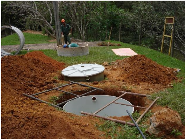
Figura 53 - Construção fossa séptica.
