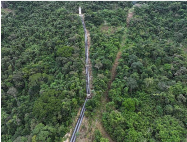
Figura 9 - Vista geral do conduto forçado e, ao fundo, a Chaminé de equilíbrio.
