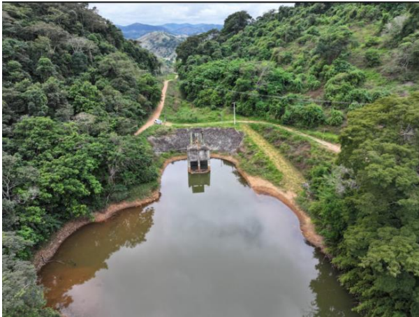
Figura 5 - Vista geral da tomada d'água.
