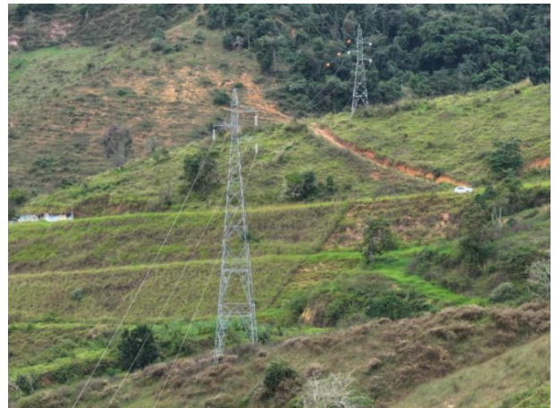
Figura 17 - Vista das torres próximo à instalação.
