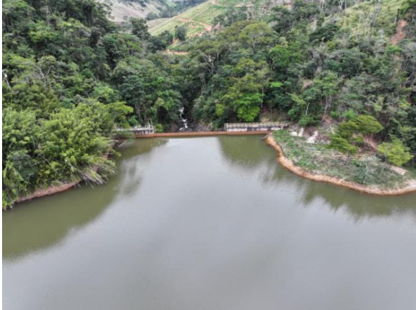
Figura 3 - Vista da barragem, à montante.
