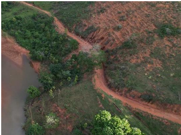
Figura 39 - Feição Erosiva 01 fora da APP.
