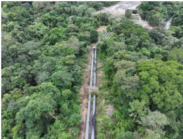
Figura 11 - Vista parcial do conduto forçado.
