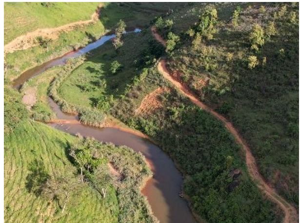
Figura 40 - Feição Erosiva 02 fora da APP.
