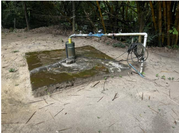
Figura 30 - Poço tubular.
