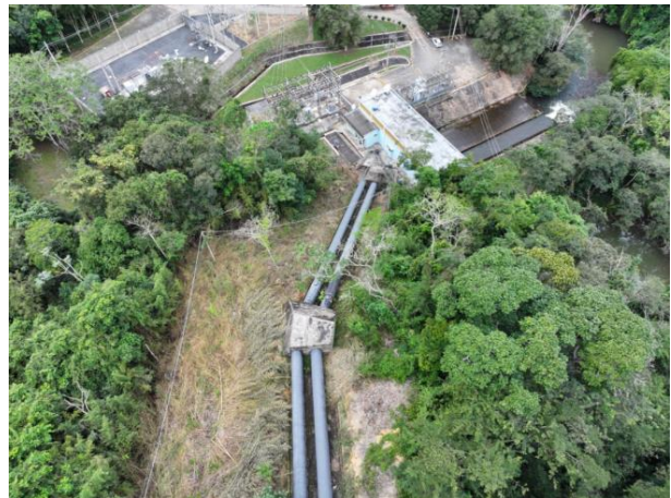
Figura 12 - Vista parcial do conduto forçado, chegando à Casa de Força.
