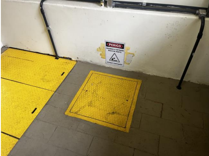
Figura 15 - Entrada do poço de drenagem.
