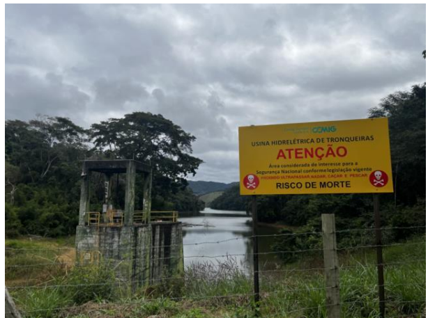
Figura 8 - Vista do portão de acesso à tomada d'água.
