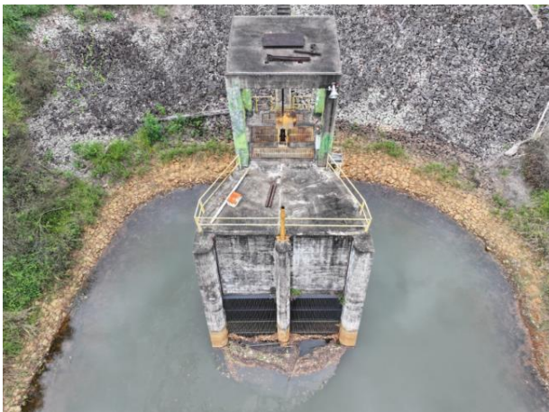
Figura 7 - Vista superior da tomada d'água.
