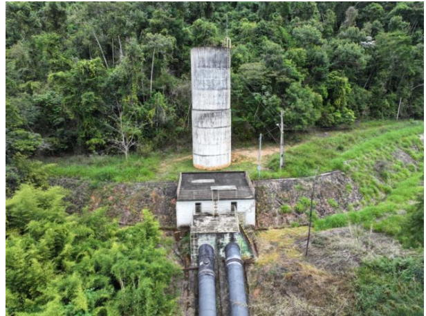
Figura 10 - Chaminé de equilíbrio e o início da tubulação forçada.
