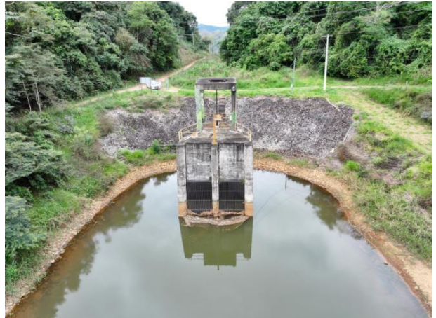
Figura 6 - Tomada d'água.
