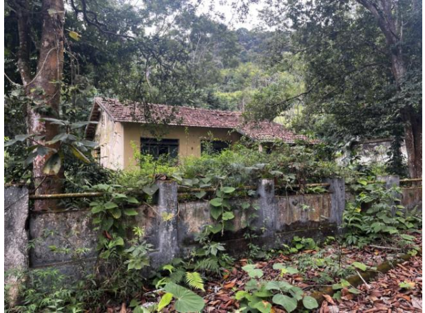
Figura 21 - Edificação na Vila, vista de frente.
