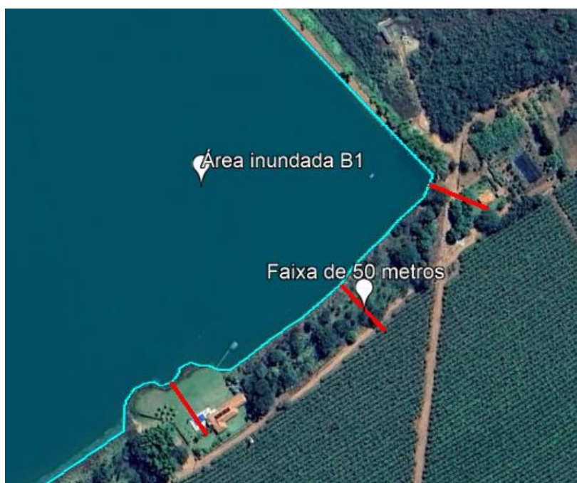
Figura 2. Detalhes do Barramento B1.
