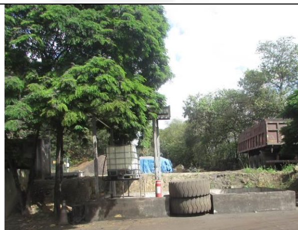
Foto 11. Bombona de óleo diesel com cobertura e bacia de contenção. Data do registro: 14/09/2017.
