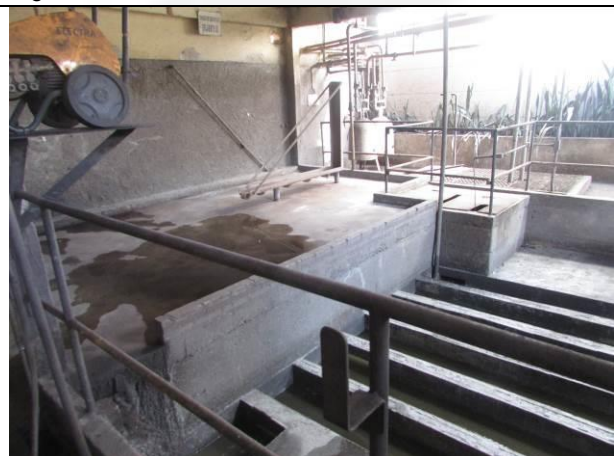
Foto 03. Detalhe chicanas - Tratamento para recirculação dos efluentes industriais. Data do registro: 14/09/2017.
