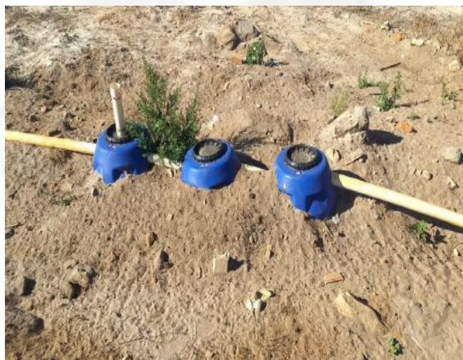
Foto 04: Sistema fossa-filtro-sumidouro existente
