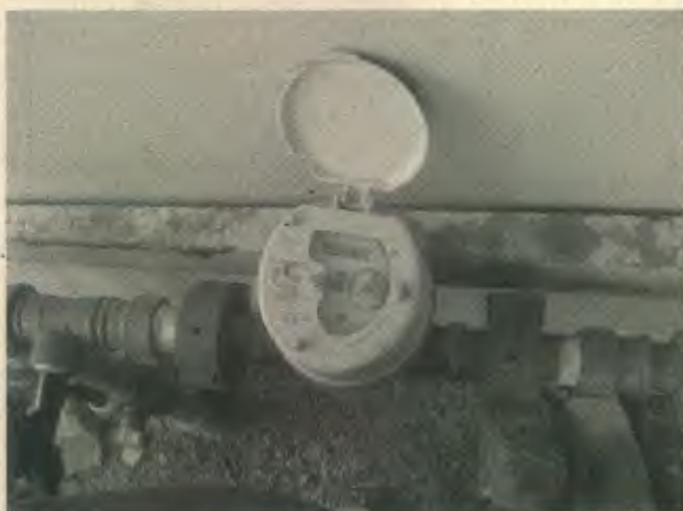
Foto 03. Hidrômetro instalado no poço tubular
