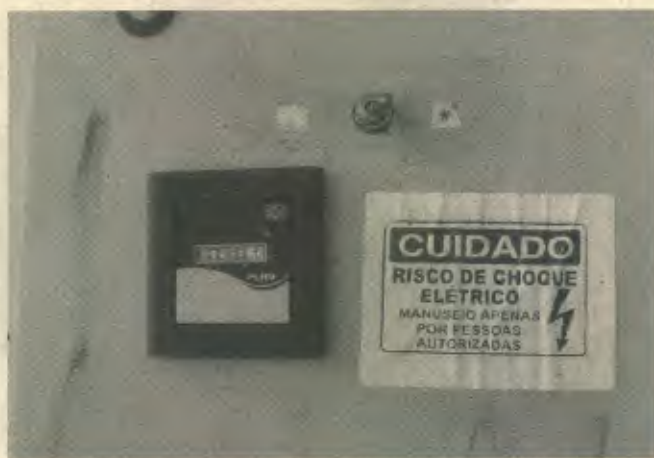
Foto 04. Horímetro instalado no poço tubular
