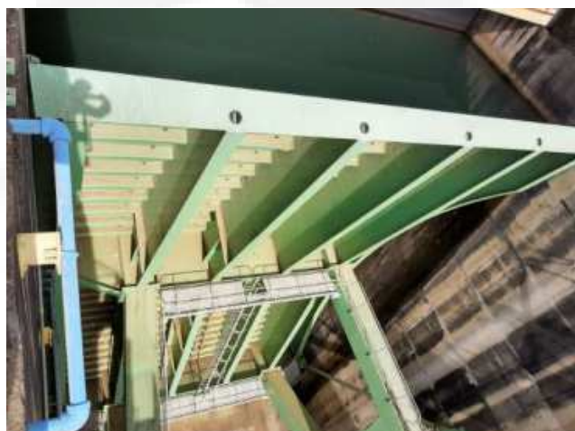
Foto 06: Comporta do Vertedouro
