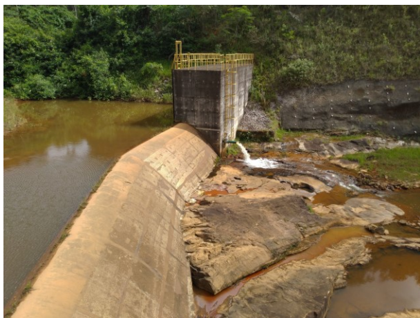
Foto 01 – Barragem vertente e dispositivo de manutenção da vazão residual (ao fundo).
