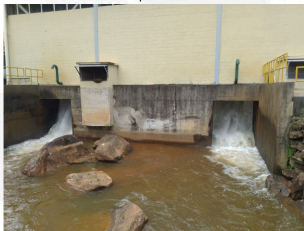
Foto 06 – Canal de fuga da casa de força.
