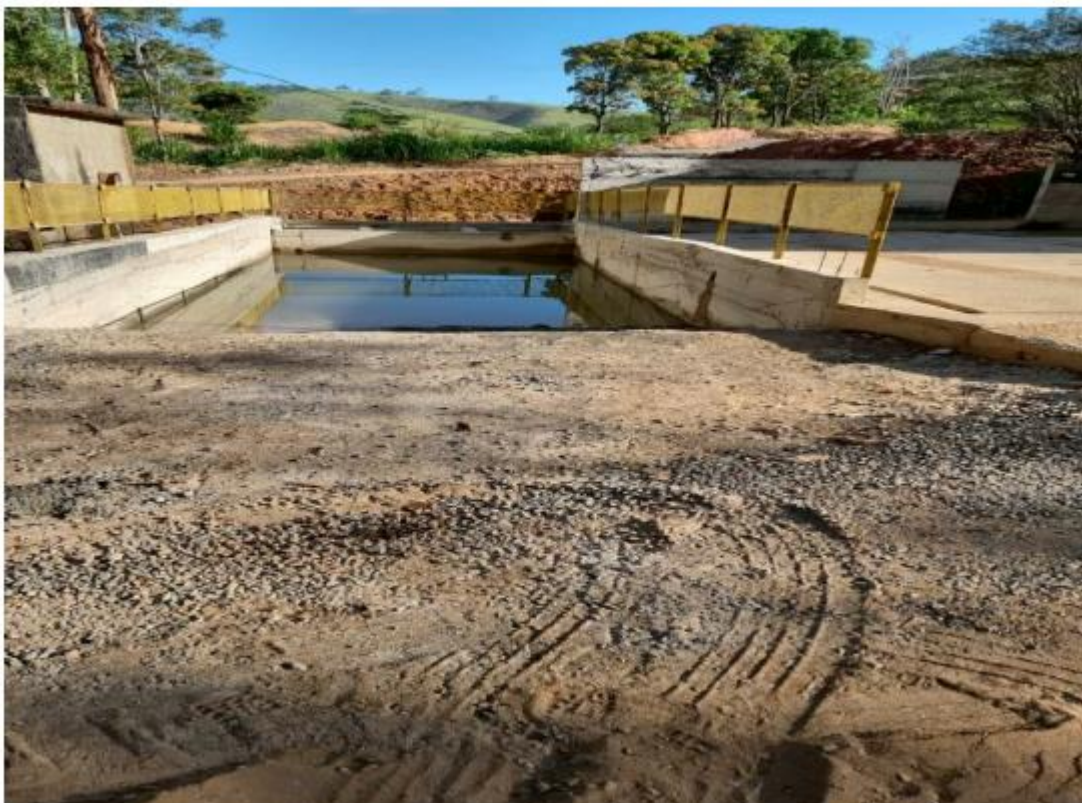
Imagem 1: Caixa de decantação, que recebe o efluente industrial do empreendimento
