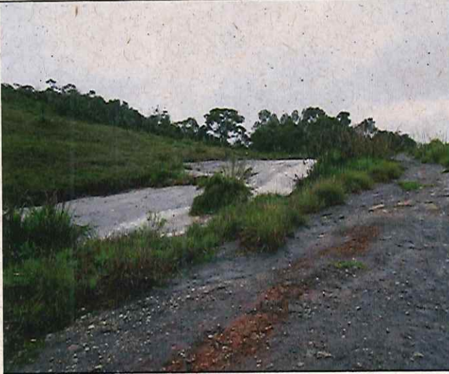
Foto 1: Córrego Pinheiro Grosso ao lado da estrada de acesso a cava da pedra
