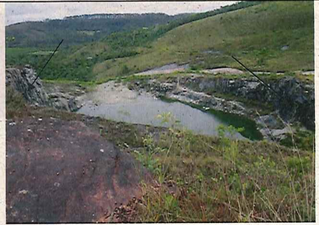
Foto 4: Vista mostrando os taludes da cava (setas negras)
