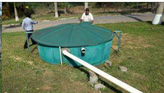
Figura 6 – Caixa efluentes pista e lavagem
