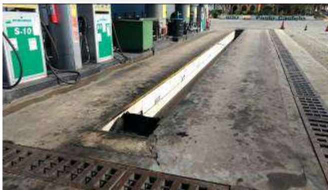
Figura 1 – Troca de óleo e canaletas
