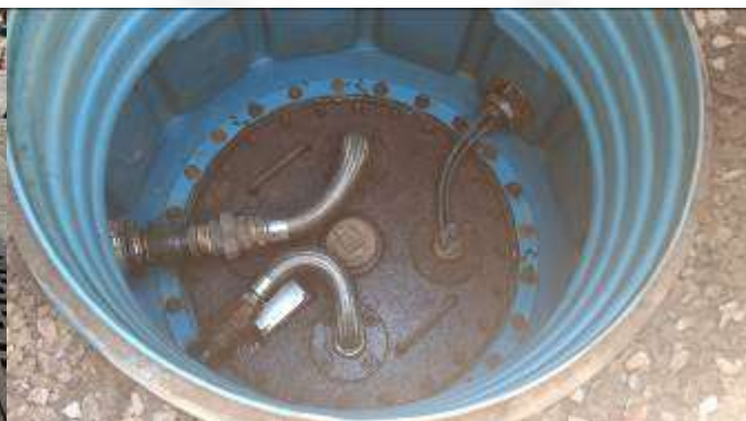
Figura 2 – Boca de visita
