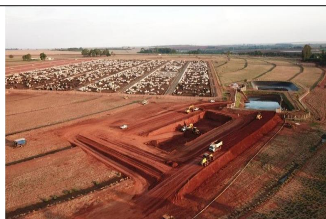
Figura 4 - Reservatórios de efluentes (novo)
