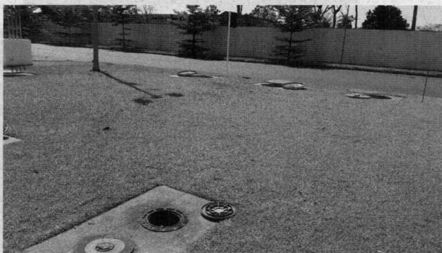
Foto 01. Área dos tanques
