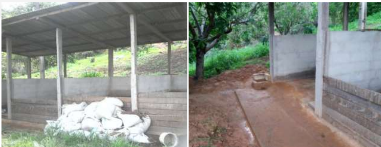
Figura 9 – Câmaras de compostagem, composta com canaleta e caixa de recolhimento de chorume.
