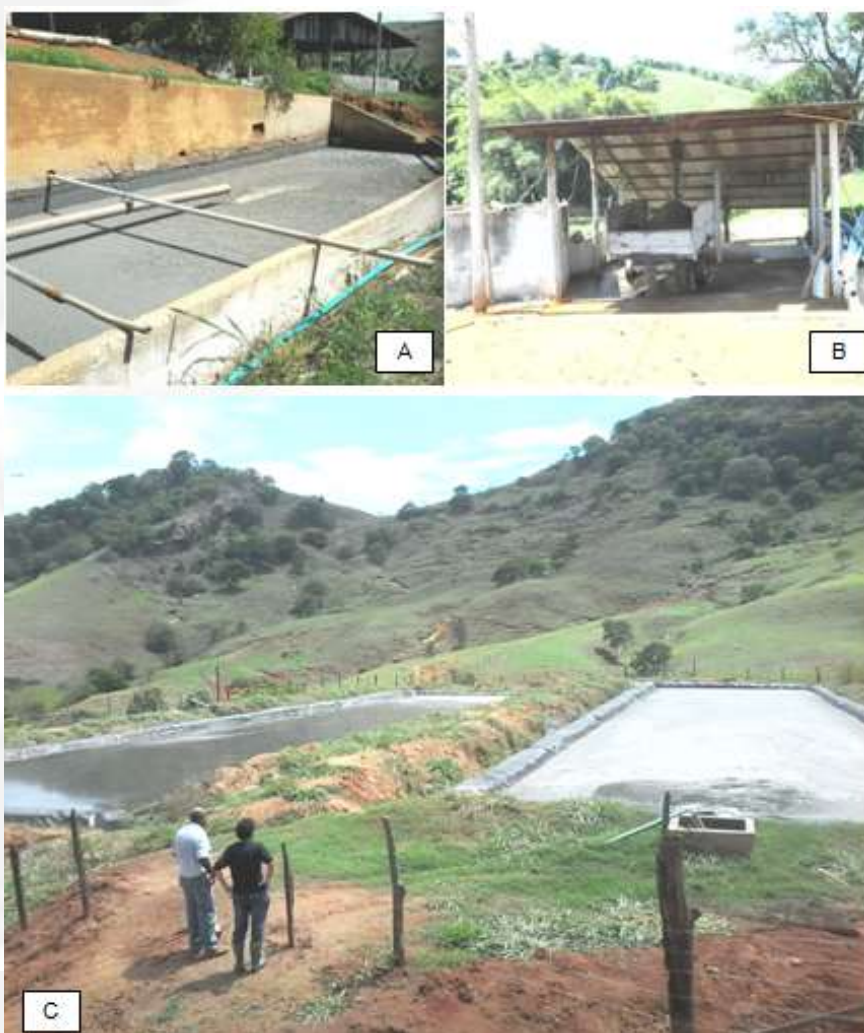
Figura 7 – Sistema de tratamento de efluentes instalado no empreendimento: (A) caixa de equalização; (B) Filtro prensa; (C) duas lagoas de tratamento e área fertirrigada ao fundo.
