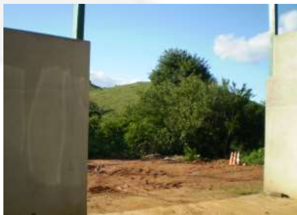
Foto 02. Pátio de manobras localizado nos fundos do terreno.
