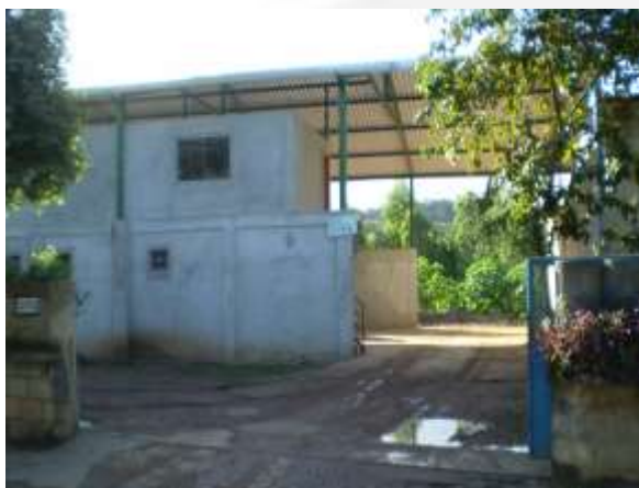
Foto 01. Vista do Galpão de reciclagem.
