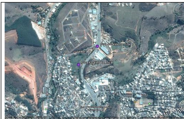
Foto 01. Visão Geral do local da canalização
