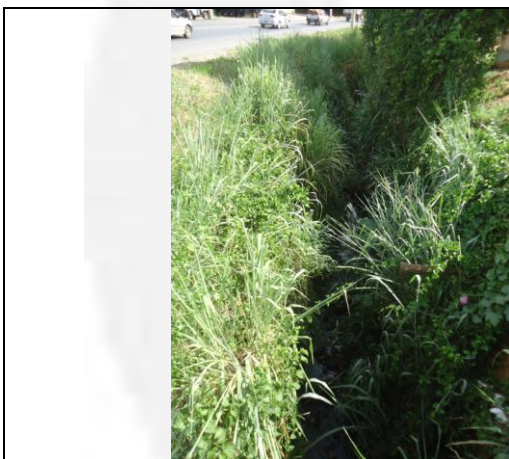
Foto 02. Córrego a ser canalizado com ponto de lançamento de efluente.
