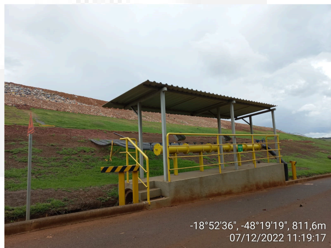
Foto 04 – Sistema de coleta de gás.
