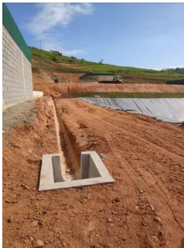
Drenagem pluvial área da ETE (aos fundos revegetação de talude)
