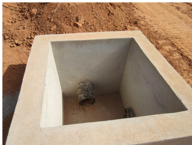
Interior das caixas de inspeção (líquido percolado)
