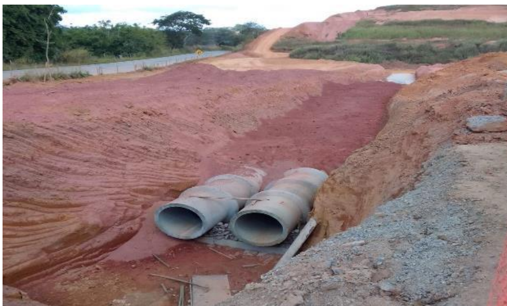
Manilhas do sistema de drenagem pluvial. Por sobre essa área será realizada a construção do trevo de acesso ao empreendimento.
