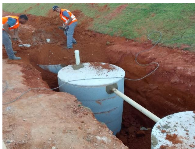
Implantação do sistema fossa séptica/filtro anaeróbio
