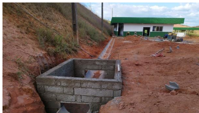
Sistema de drenagem pluvial/caixas de passagem. Revegetação de talude mediante microcoveamento e hidrossemeadura.
