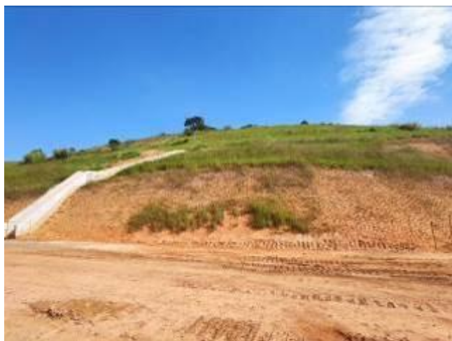
Escada hidráulica e revegetação de taludes
