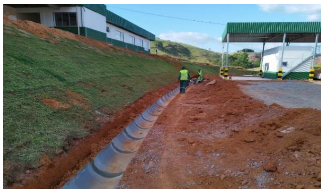
Canaletas de drenagem de água pluvial/revegetação de talude com placas de grama (aos fundos à esquerda prédio administrativo e à direita prédio da balança).
