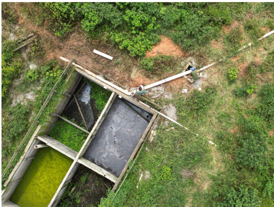
Figura 6: Equipe de manutenção realizando reparos na tubulação de condução do efluente bruto. Fonte: fiscalização “in loco”.
