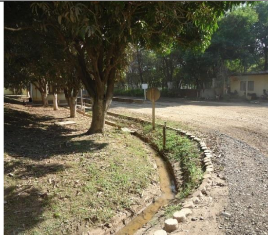
Foto 07. Sistema de drenagem pluvial.
