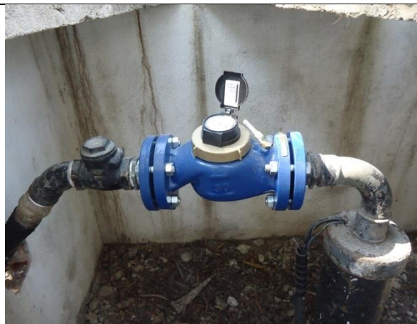
Foto 09. Poço tubular com hidrômetro.
