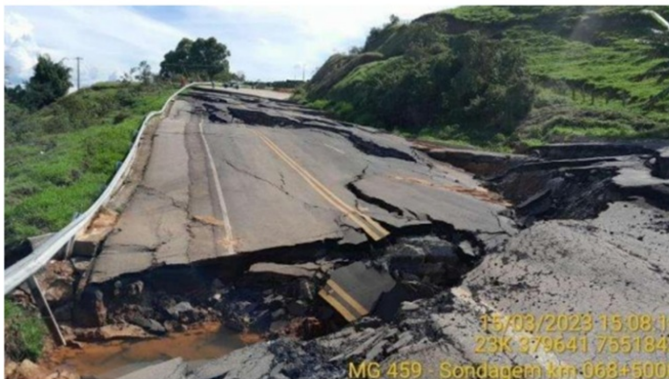
Imagem 1: Vista geral de afundamento da pista, km 68 da BR 459 (março de 2023)
