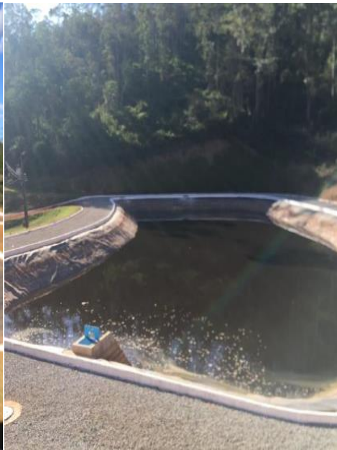
Figura 10: Lagoa anaeróbica seguida da lagoa facultativa após a reforma da impermeabilização. Figura 11: Nova lagoa de maturação.
