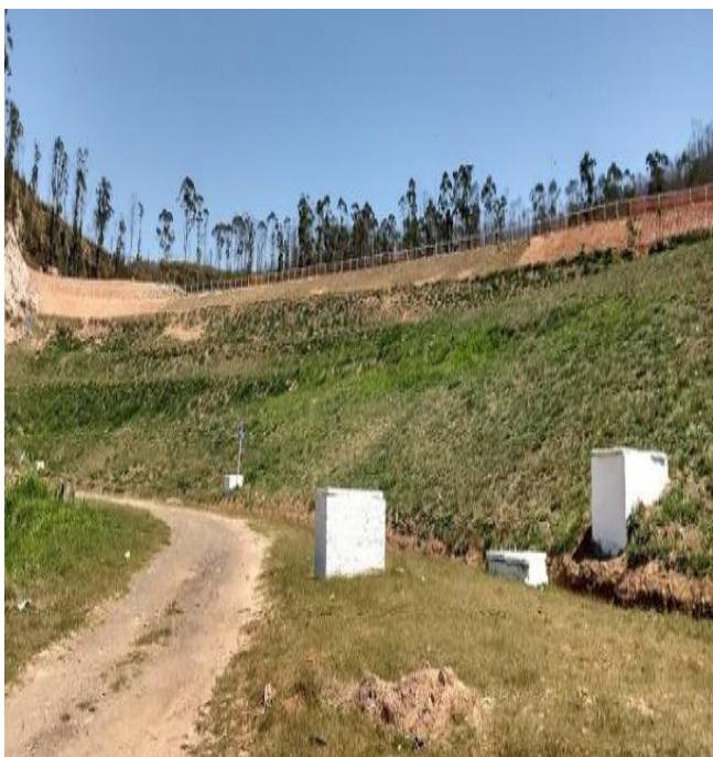
Foto 2: Células encerradas e revegetadas.
