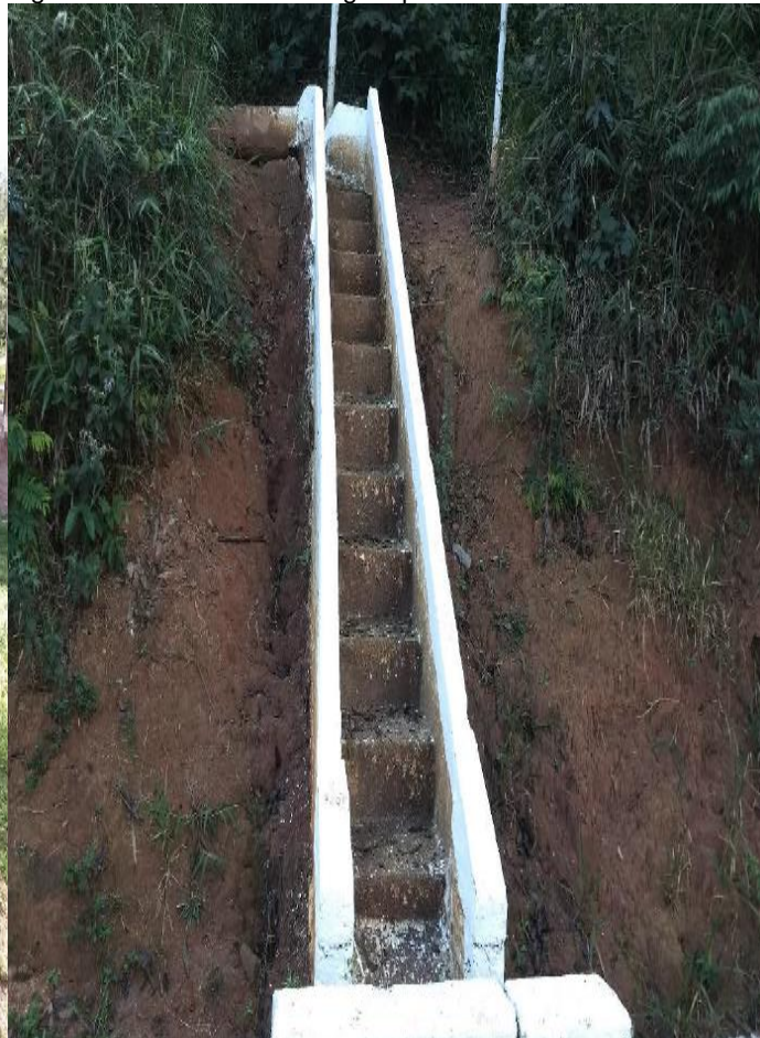
Figura 08: Sistema de drenagem pluvial do CPGRS.
