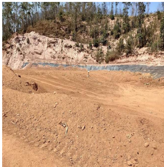
Foto 3: Recobrimento de célula do Aterro.
