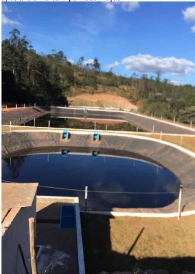
Figura 10: Lagoa anaeróbica seguida da lagoa facultativa após a reforma da impermeabilização. Figura 11: Nova lagoa de maturação.
