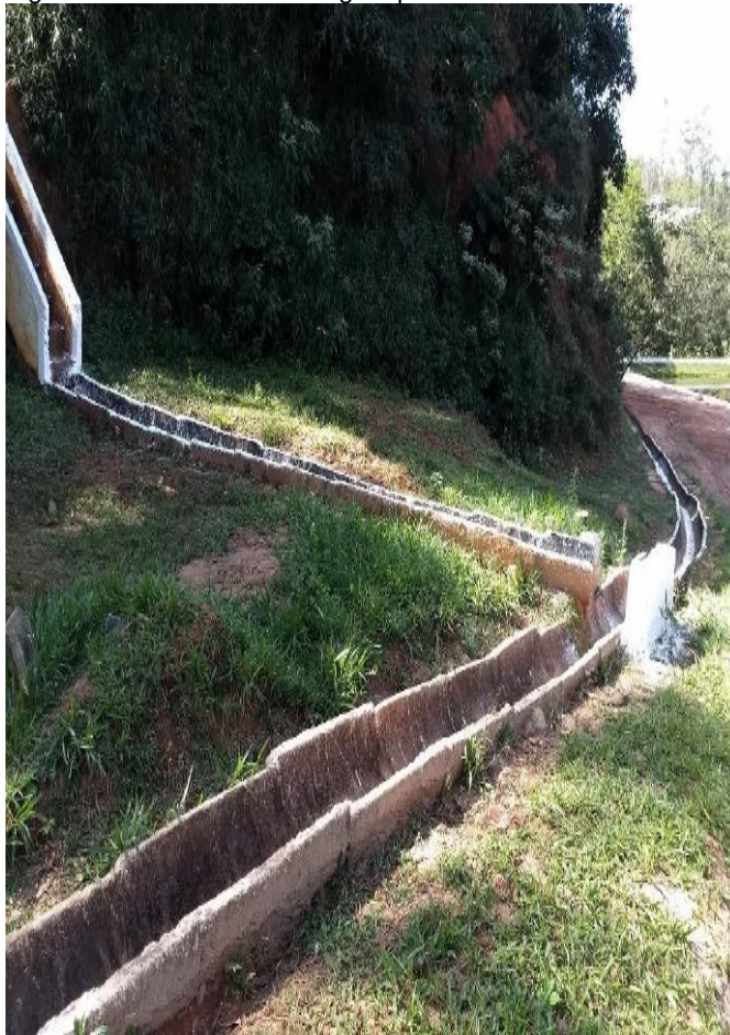
Figura 07: Sistema de drenagem pluvial do CPGRS.
