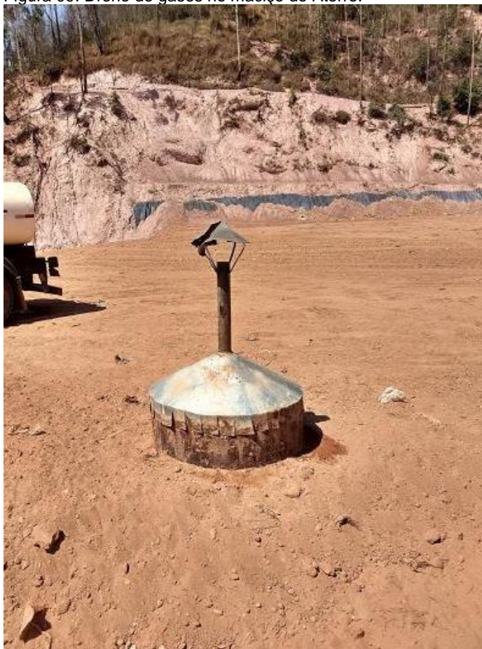
Figura 09: Dreno de gases no maciço do Aterro.
