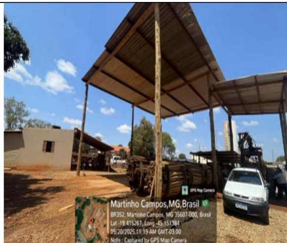
Foto 01. Área com Autoclave e tanque
