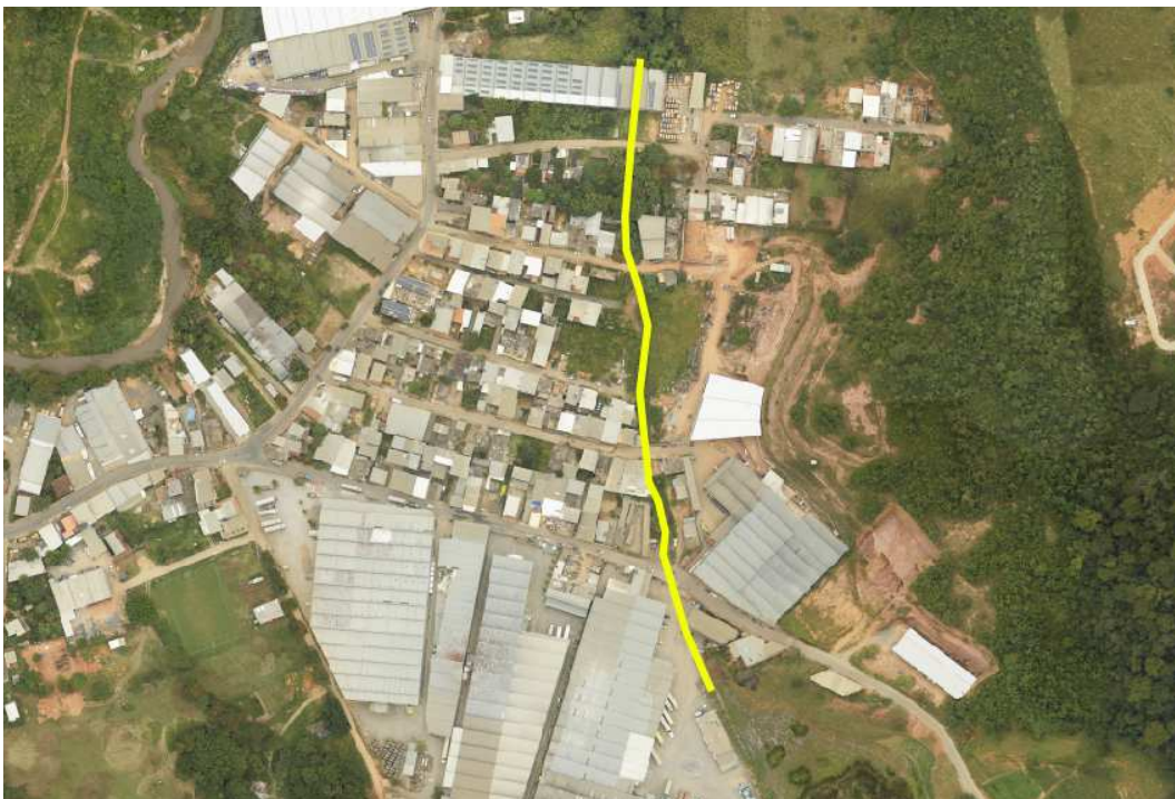
Fig. 1 - Imagem aérea de Maio de 2021 demonstrando o local da canalização com extensão de 425 metros. Fonte: Base cartográfica do Município de Ubá.
