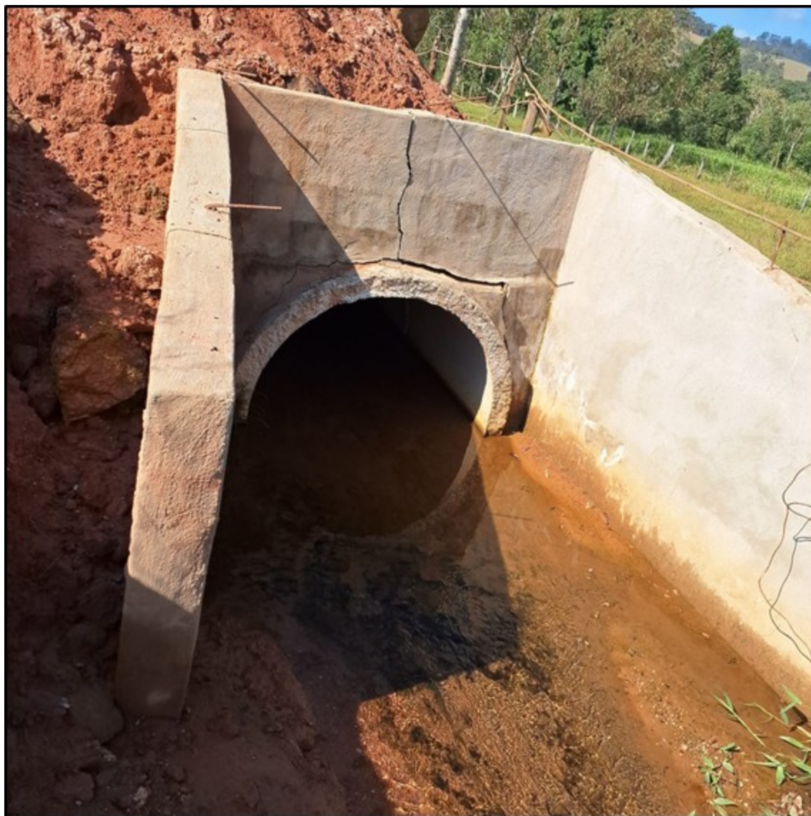
Imagem 6 - Final da canalização de curso d'água com aterro da app no empreendimento Centro Logístico Spartacus Pericos.
