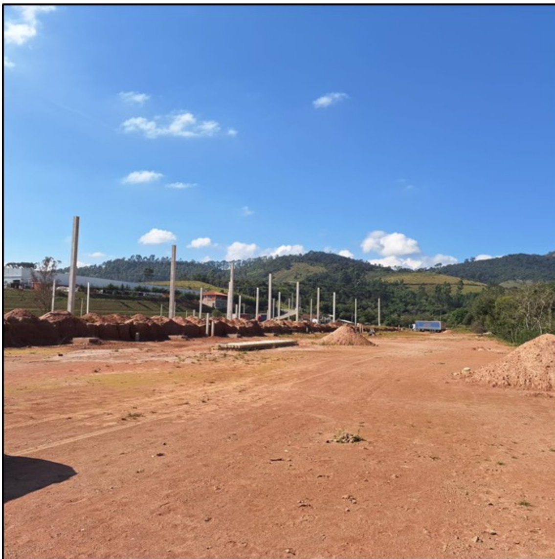
Imagem 3 - Visão geral do empreendimento com área de app e canalização aterradas (direita).
