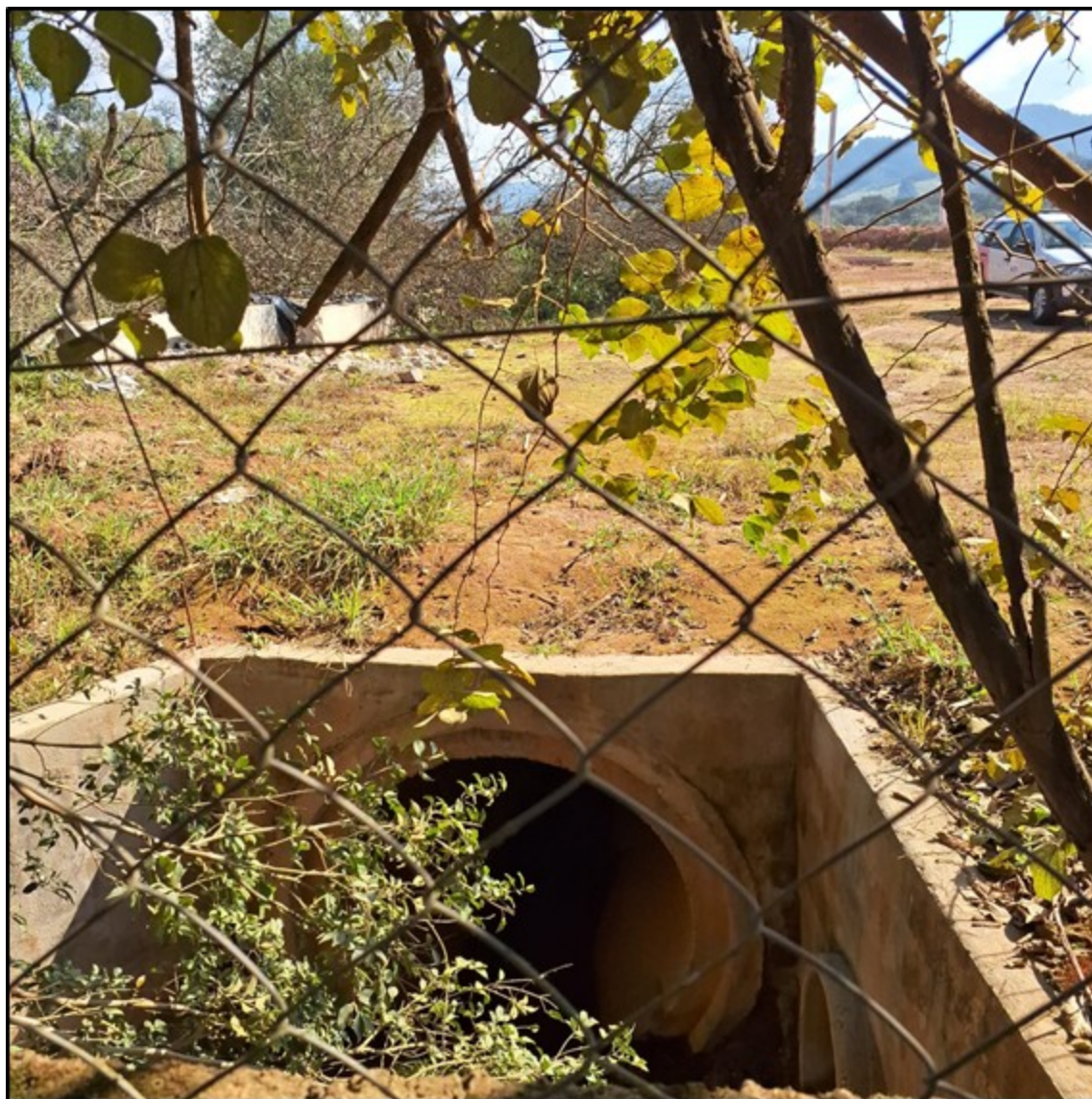
Imagem 5 - Início da canalização de curso d'água com aterro da app no empreendimento Centro Logístico Spartacus Pericos.
