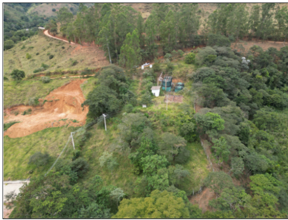
Foto 1 - Fotografia aérea da área requerida para intervenção ambiental, com destaque da implantação da ETE São José do Jacuri e da área utilizada como inventário testemunho (à direita).
