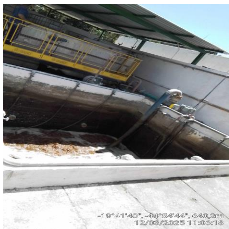
Foto 01. Estação de Tratamento de Efluentes Industriais.
